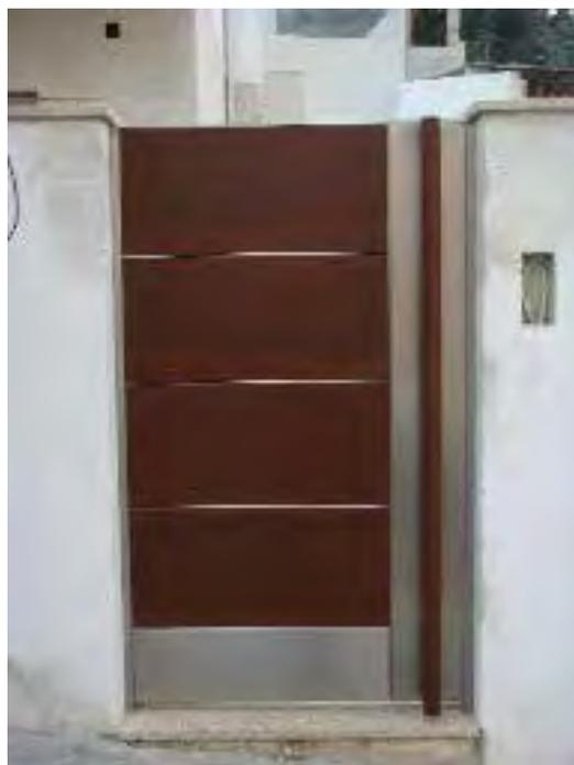
Portões com estrutura em inox e almofadas em alumínio. Com possibilidade de personalizar o portão colocando a quantidade de inox onde pretender e na dimensão desejada, adaptando as chapas de alumínio ao resto da estrutura na cor solicitada. A versatilidade do material permite inúmeras e criativas aplicações, tornando-se uma solução técnica e decorativa da fachada.
